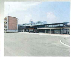
気仙沼市東日本大震災遺構伝承館
